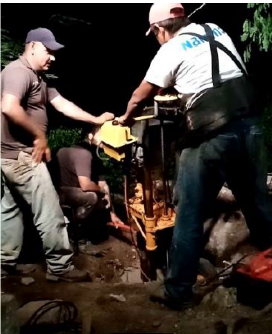
Vistas de la ejecución del sondeo 1.
